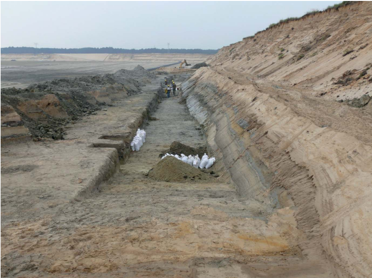
Abbildung 9: Durch den kleinen Bagger (hier im Hintergrund) kann die Berme Schicht für Schicht abgetragen werden. Dadurch werden Profile generiert, die dann im Folgenden untersucht und beprobt werden.
